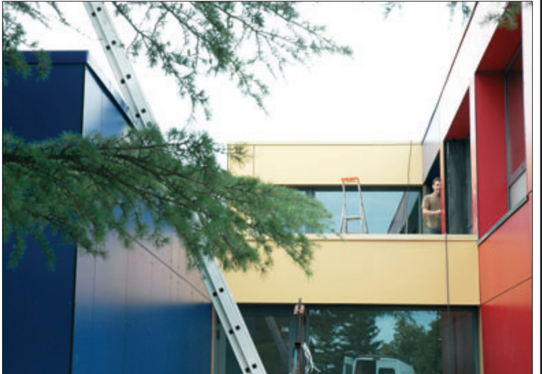
De belles couleurs qui ne passeront pas inaperçues à l'école Colette où les façades Nord et Est sont en cours de réfection.
