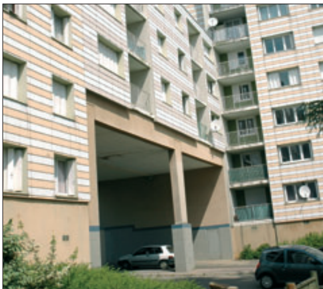
La destruction de l'immeuble porche va débuter très prochainement, dès que l'immeuble sera totalement vide de ses locataires.
